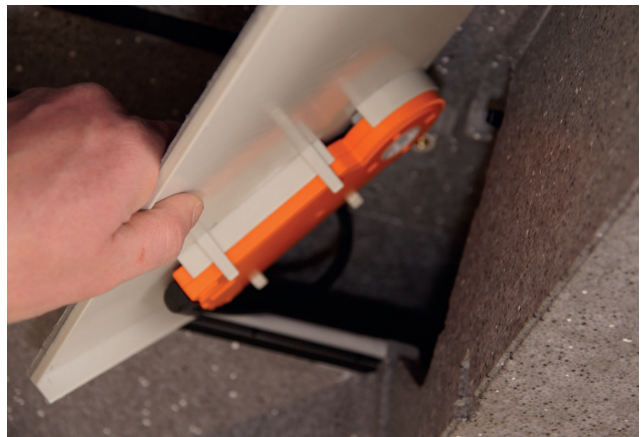
Fjern bypass-aktuator
